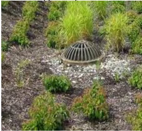
Впускное отверстие для приёма ливневых вод с тротуара
