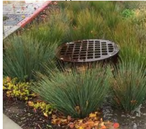
Впускное отверстие для приёма ливневых вод с тротуара
