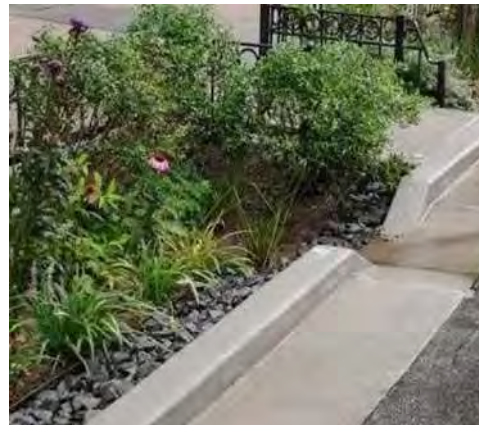
Впускное отверстие для приёма ливневых вод с тротуара
