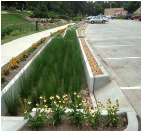
Впускное отверстие для приёма ливневых вод с тротуара
